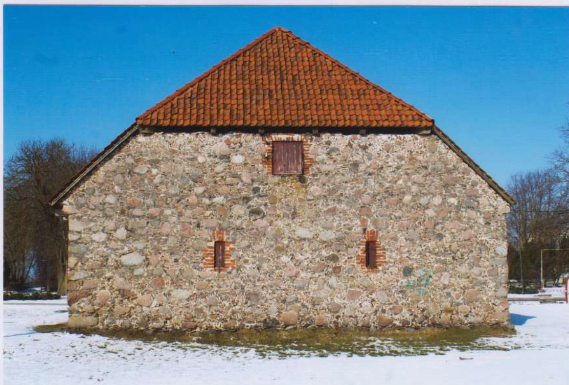
7. fotoattēls. Skats uz fasādi asīs A-B. 22.02.2018.
