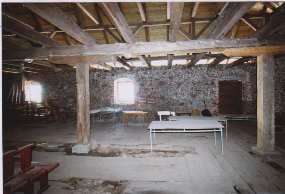
12. fotoattēls. Skats pirmā stāva telpā uz dienvidiem - fasādi asīs 1-2. 22.02.2018.
